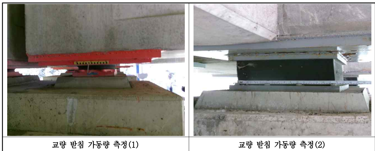
【사진 8.3.15】교량받침 이동량 측정
