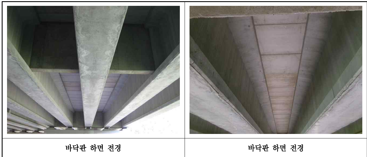
【사진 8.3.2】 바닥판하면 전경
