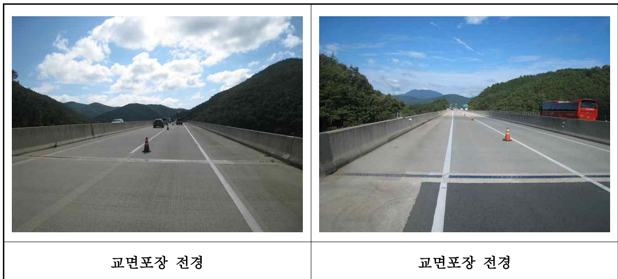
【사진 8.3.44】 교면포장 전경
