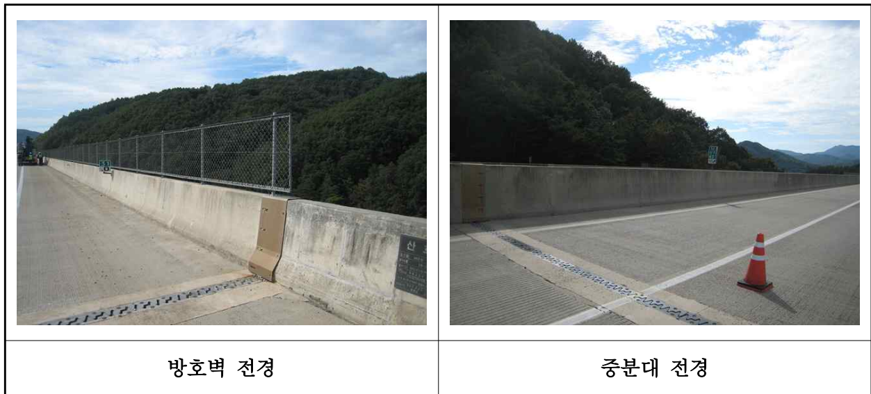
【사진 8.3.23】 방호벽 및 중앙분리대 전경
