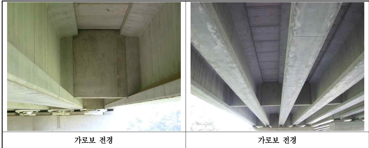
【사진 8.3.31】 가로보 전경
