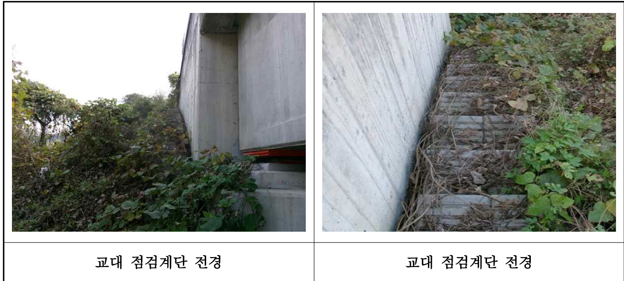
【사진 8.3.25】 교량 점검시설 전경
