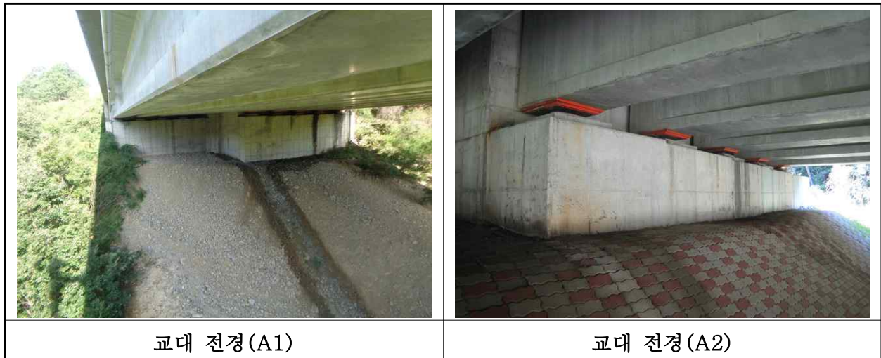
【사진 8.3.33】 교대 전경
