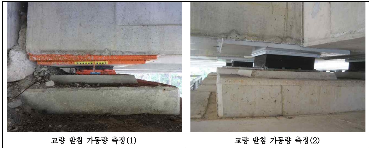
【사진 8.3.40】 교량받침 이동량 측정
