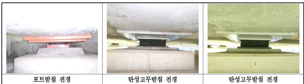
【사진 8.3.37】 교량받침 전경
