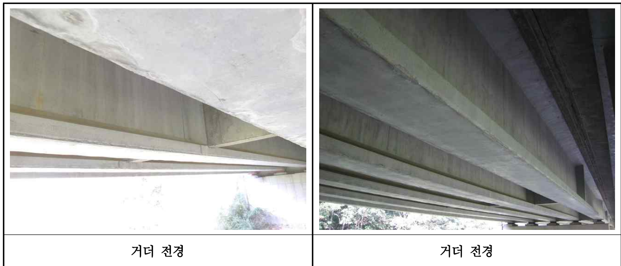
【사진 8.3.29】 거더 전경
