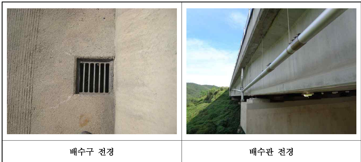
【사진 8.3.21】 배수시설 전경
