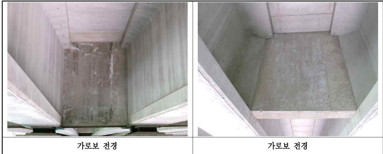
【사진 8.3.6】 가로보 전경
