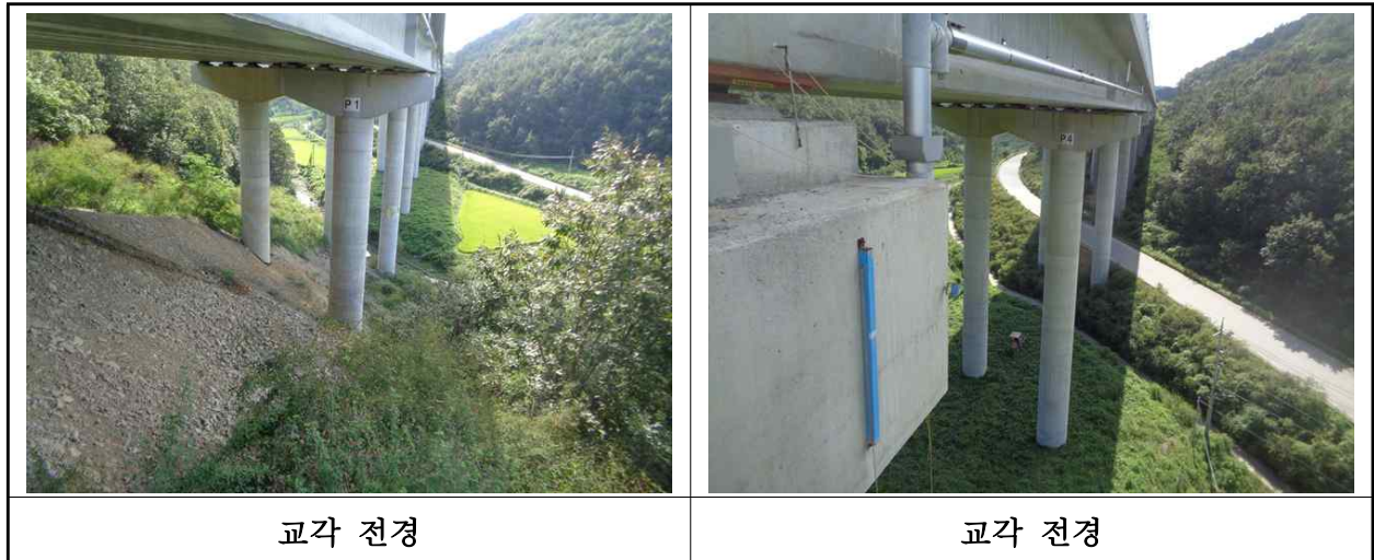
【사진 8.3.35】 교각 전경
